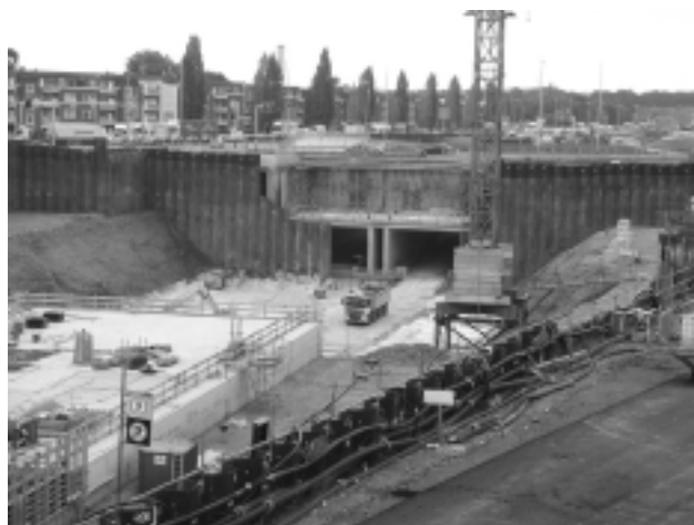
Budowa tunelu. Stan zaawansowania robót na 30 sierpnia 2013 r.
