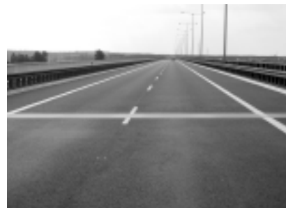
Fot. 2. Most autostradowy (A1) na Wiśle koło Torunia; warstwa ścieralna z SMA
