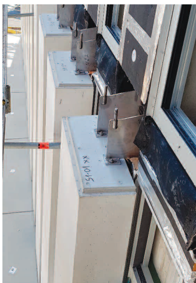
Fot. 2. Przykład zamocowania prefabrykatów za pomocą wieszaków systemu NOVA
