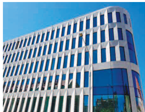
Fot. 3. Budynek Retro Office, Wrocław
