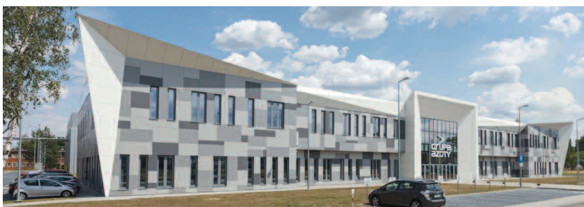
Fot. 2. Elewacja budynku Centrum Badawczo-Rozwojowego Grupy „Azoty”
