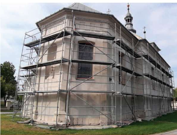
Fot. 1. Renowacja obiektu sakralnego za pomocą SYSTEMU TYNKÓW RENOWACYJNYCH ATLAS
