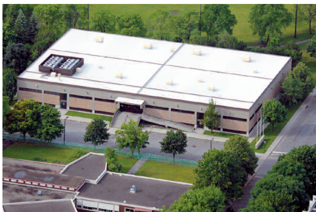
Referencja SOPREMA – Lodowisko Arena Bill-Durnan w Montrealu
