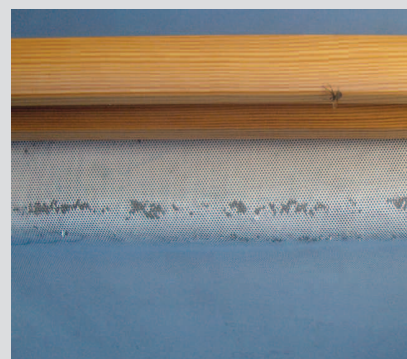
Fot. 1. Uszkodzenia spodniej warstwy MWK objawiają się w postaci pęknięć, a następnie wykruszeń filmu membrany i są wywołane przez promieniowanie UV. MWK jest ułożona wokół okna dachowego doświetlającego poddasze mieszkalne i nieosłonięta przez 3 lata
