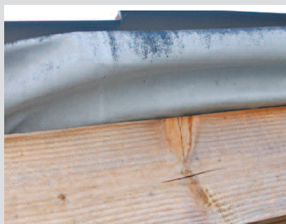
Fot. 2. Uszkodzenia wywołane przez promieniowanie UV spodniej warstwy MWK, ułożonej pod blachodachówką na krawędzi w okapie ściany szczytowej i nieosłoniętej przez 2 lata po ułożeniu. Jest to szczyt dachu po stronie południowo-wschodniej połaci
