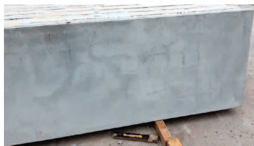
Fot. 1. Przebarwienia powierzchni prefabrykowanego elementu betonowego
