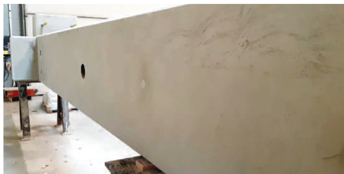
Fot. 6. Slup. Brak tzw. szwów (linii) w miejscu styku kolejnych mieszanek ASCC
