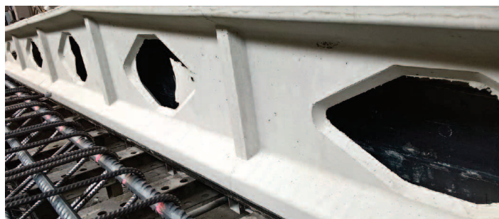
Fot. 5. Dźwigar dachowy. Brak tzw. szwów (linii) w miejscu styku kolejnych mieszanek SCC
