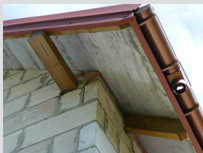
Fot. 4. Okap dachu po dwóch latach od zakończenia prac dekarских. Liczne uszkodzenia wywołane działaniem promieniowania UV zawartego w świetle dziennym. W takich miejscach światło odbite od murów dostarcza dużo UV do MWK
