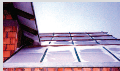
Fot. 3. Na tej samej ulicy co budynek z dachem pokazanym na fotografii 1, dach został osłonięty tymczasowo FWK na zimę. Po zimie należałoby zdjąć taką folię, ponieważ na pewno została uszkodzona. Uszkodzenie UV objawi się po kilku latach, bo proces rozpadu trwa długo
