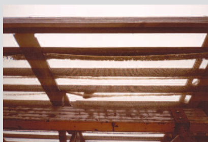
Fot. 1. Dach z 2001 r., kiedy jeszcze stosowano folie wstępnego krycia (FWK), które były mniej odporne na działanie promieniowania UV. Po dwóch latach (czasami szybciej) po folii zostawała tylko siatka wzmacniająca. Polietylen zamienił się w płatki i opadł
