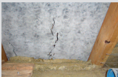
Fot. 8. W trakcie układania termoizolacji na części dachu odkryto pęknięcia membrany MWK. Przerwa między ułożeniem pokrycia a ułożeniem wełny wynosiła 3 lata. Poddasze przeznaczone do zamieszkania było w tym czasie doświetlone oknami dachowymi
