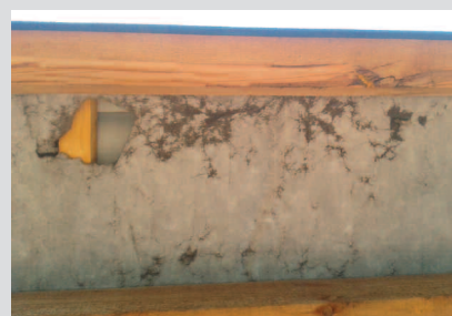
Fot. 6. Okap znajdujący się po stronie zachodniej budynku po siedmiu latach od wykonania. Tam światło słoneczne pada intensywnie od rana do południa
