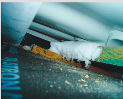
Fot. 10. Nie ma pokryć dachowych układanych na latach, które byłyby szczelne na światło i śnieg. W każdym pokryciu jest dużo szczelin, ponieważ przez dach przechodzi dużo instalacji, a połacie są łączone za pomocą koszy i naroży. To jest kosz dachowy
