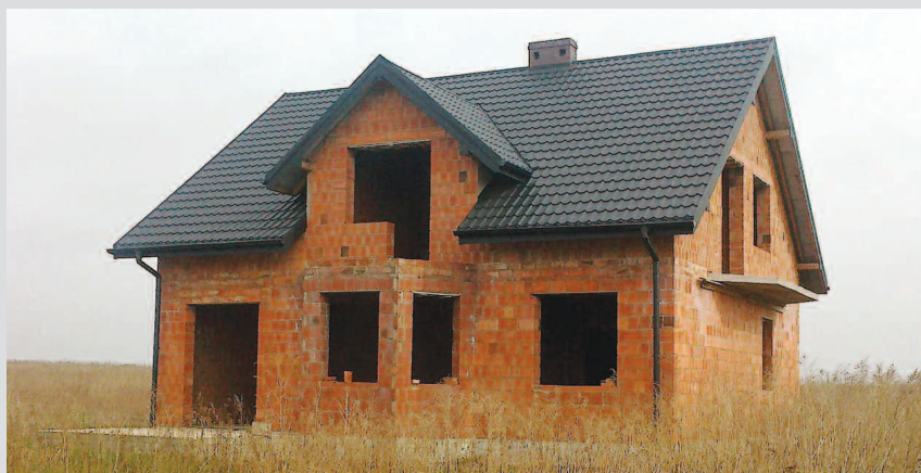
Fot. 5. Budynek stał siedem lat w takim stanie. Przez otwory okienne na poddaszu dostawało się światło słoneczne. Efekty można zobaczyć na fotografiach 6 i 7. Największe zniszczenie UV dokonało na MWK odkrytej w okapach (fotografia 6)
