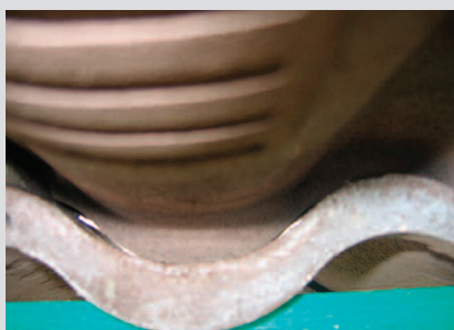
Fot. 9. Widok od dołu dachówki betonowej, która nie ma zamków poziomych. Wszystkie dachówki w zależności od typu, kształtu i wielkości odchyłek od płaskości połaci dachowej mają na stykach takie szczeliny, ale promieniowania UV jest tam mało, ponieważ rozprasza się w czasie odbicia światła
