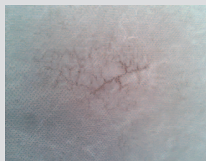
Fot. 7. Wnętrze poddasza. Uszkodzony fragment MWK jest po stronie zachodniej dachu. Na stronie wschodniej nie było tak dobrze widać uszkodzeń, ale na pewno po siedmiu latach i na tej mało doświetlonej MWK na pewno są uszkodzenia
