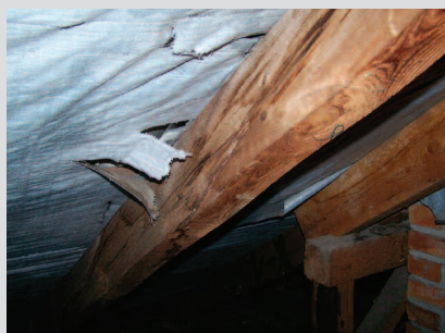
Fot. 2. Dwuwarstwowa FWK wzmacniana tkaniną (nazywana „silwer”) rozpadła się, gdyż służyła jako tymczasowe. Nikt z mieszkańców nie zauważył, kiedy pojawiły się pierwsze pęknięcia, ponieważ poddasze jest niemieszkalne i nie było przecieków, chociaż są ślady na belkach
