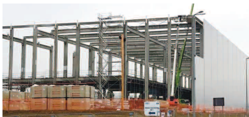
Realizacja rozbudowy fabryki Grupy PSA w Gliwicach
