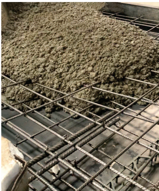
Zbrojenie polimerowe MC-Fibre zastosowane przy produkcji płyt drogowych
