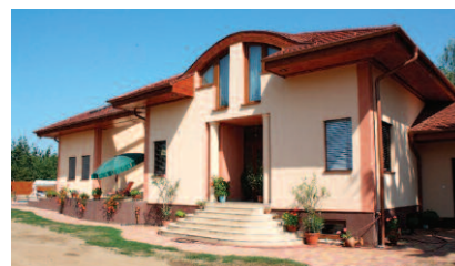
Fot. 1. Eksperymentalny budynek w Nyiregyhaza, Węgry Źródło własne Photo 1. Experimental building in Nyiregyhaza, Hungary Own source
