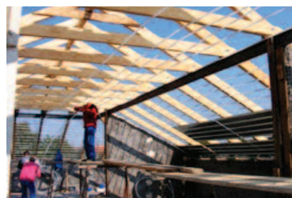
Fot. 3. Ułożenie węzownicy systemu ATI pod krokiewiami Źródło własne Photo 3. Placement of the ATI system coil under rafters Own source
