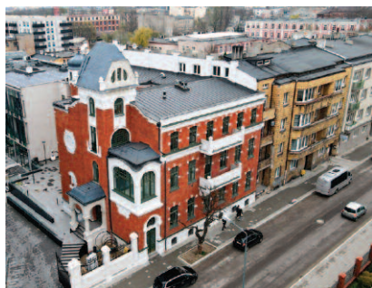
Fot. 4. Wymiana stropów w kamienicy przy ul. Rewolucji 1905 w Łodzi
