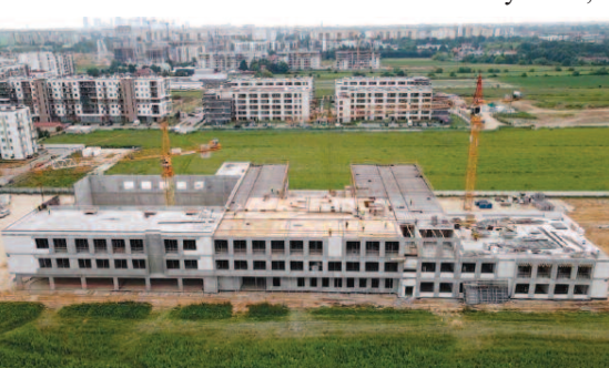
Fot. 1. Zastosowanie stropów RECTOBETON w szkole podstawowej w Warszawie
