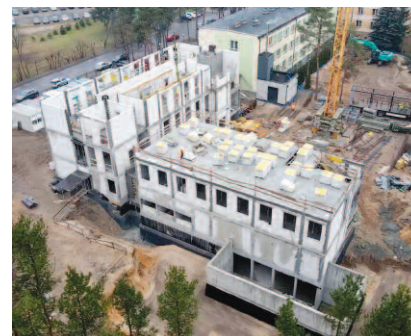
Fot. 3. Rozbudowa Komendy Policji w Otwocku
