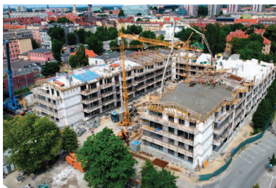
Fot. 5. Realizacja budynku wielorodzinnego przy ul. Targowej w Opolu
