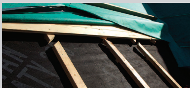
Fot. 1. Dzielone kontrłaty ułatwiają wymianę powietrza w szczelinie wentylacyjnej wykonanej pod poszyciem z matą bitumiczną
