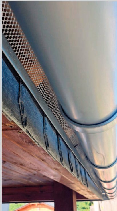
Fot. 1. Okap z rynną wysoką, czyli mocowaną nad wlotem powietrza, osłoniętym taśmą z blachy perforowanej wykrojonej na miarę
