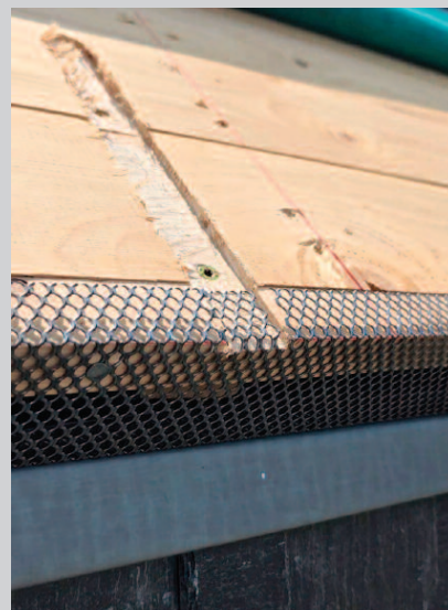
Fot. 2. Wcięcie pod płaskownik tworzący uchwyty rynny (rynajzę) wyfrezowane w deskach poszycia. O tym, czy okap będzie miał rynnę wysoką czy niską, decyduje długość pionowego fragmentu płaskownika
