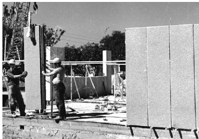
Fot. 15. Montaż budynku z dyli z ABK Fot. archiwum CEBET
