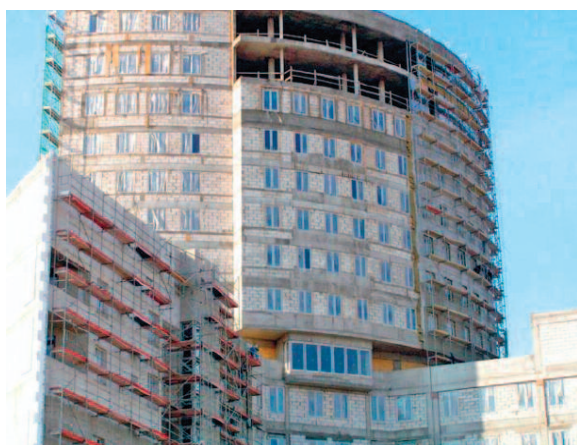
Fot. 24. Budynek mieszkalny ze ścianami wypełnionymi z betonu komórkowego Fot. archiwum autorów
