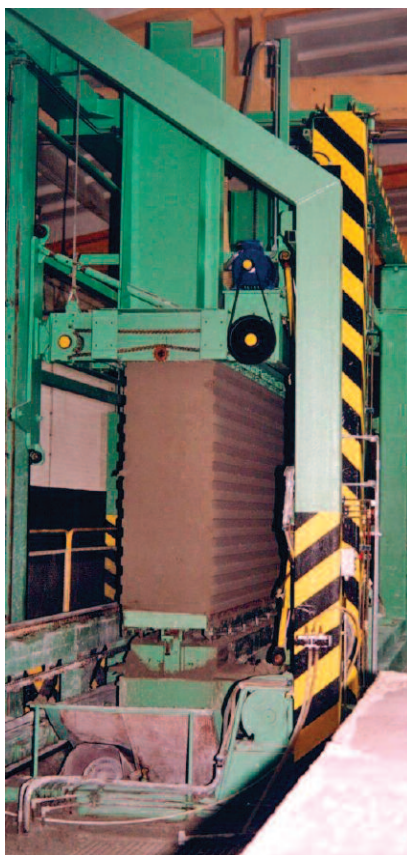
Fot. 19. Węzeł krojenia bloku masy ABK o długości 3 m – z obrotem (Śniadowo 1998 r.) Fot. archiwum autorów
