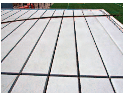
Fot. 26. Strop z elementów zbrojonych z ABK (2022 r.) Fot. Termalica [12]
