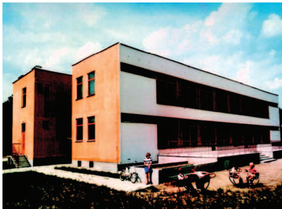
Fot. 17. Przedszkole – budynek z elementów pasmowych z betonu komórkowego Fot. archiwum CEBET
