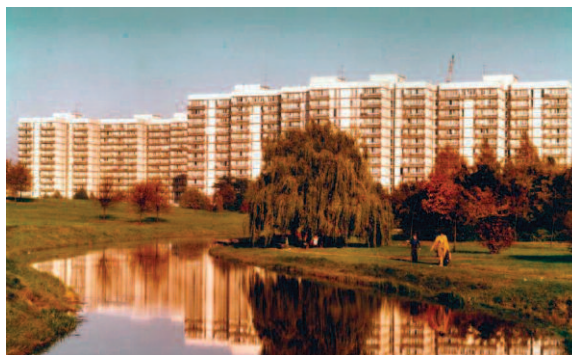
Fot. 18. Osiedle mieszkaniowe w Lublinie – budynki wielokondygnacyjne z zastosowaniem płyt scalonych z ABK Fot. archiwum CEBET
