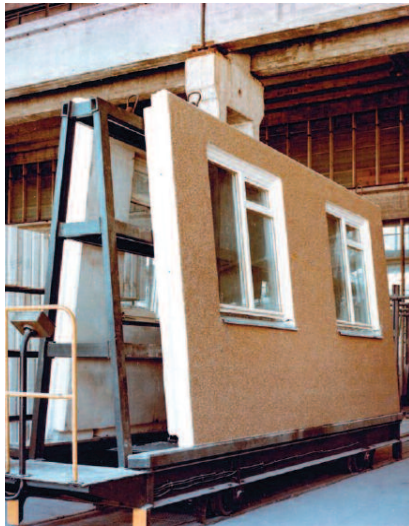
Fot. 14. Płyta scalona z pełnym fabrycznym wykończeniem z zakładu w Puławach (1973 r.) Fot. archiwum CEBET
