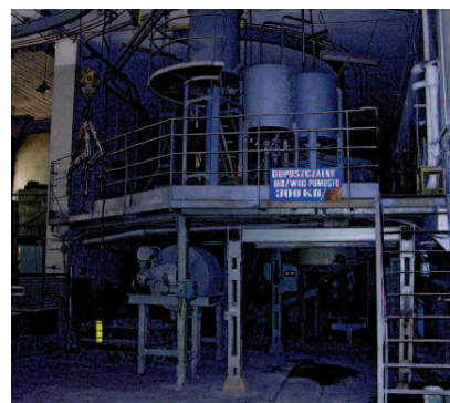
Fot. 3. Dozownia i mieszarka w hali półtechniki CEBET
