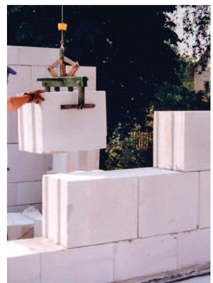
Fot. 23. Montaż ściany zewnętrznej z elementów z ABK o zwiększonej objętości (Śniadowo) Fot. archiwum autorów
