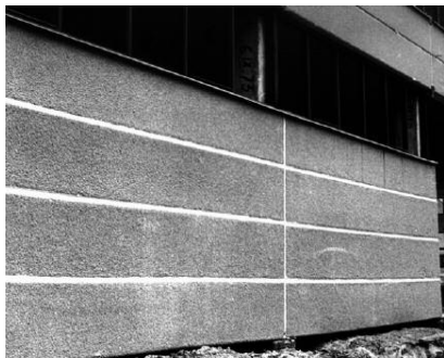
Fot. 16. Hala przemysłowa z dyli zbrojonych długości 6 m z betonu komórkowego Fot. archiwum CEBET
