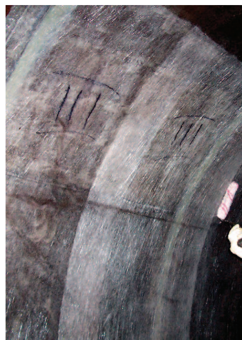
Photo 3. Applying a polyester-glass laminate to the inner surface of the tank shell Fot. 3. Nakładanie laminatu poliestrowo-szklanego na wewnętrzną powierzchnię płaszczu zbiornika
