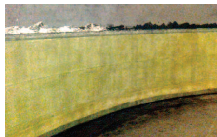
Fot. 1. Naprawa przydennej części zbiornika stalowego z użyciem laminatu poliestrowo-szklanego
