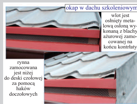
Fot. 4. Ekspnat szkoleniowy. Wlot do szczeliny wentylacyjnej jest nad rynną (wersja z rysunku 1b). Tak zamocowana rynna nazywa się „niską”, ponieważ jest nisko zamontowana na hakach doczołowych
