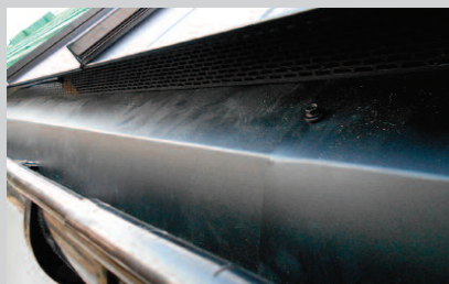
Fot. 2. Dach pokryty blaszanymi rąbkopodobnymi panelami zatraskowymi w trakcie prac dekarских. Kratka z PCW osłaniająca wlot do szczeliny wentylacyjnej została zamocowana dołaty okapowej i kontrłat
