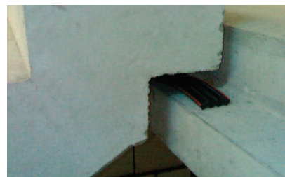
Fot. 7. Podkładka elastomerowa pod elementem [5]
