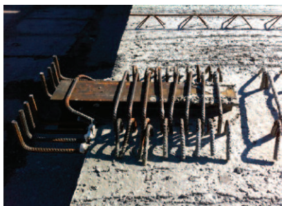
Fot. 1. Wysuwany łącznik np. do mocowania biegów schodowych z zapewnieniem izolacyjności akustycznej [5]
