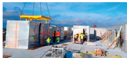
Fot. 3. Podnoszenie i montaż modułu łazienkowego
