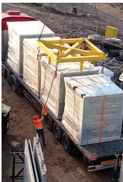
Fot. 2. Zabezpieczenie modułów na czas transportu z fabryki i montażu w miejscu docelowego zastosowania
