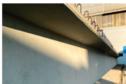
Fot. 2. Prawidłowo wykonana belka
