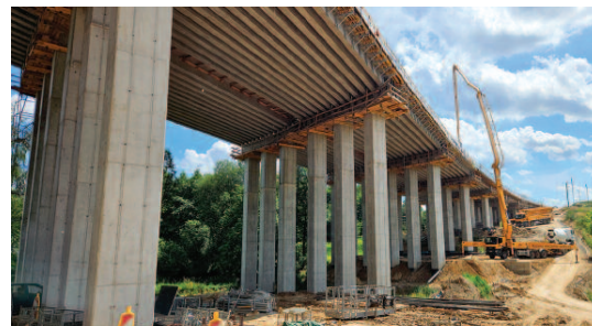
Fot. 1. Budowa obwodnicy Opatowa
