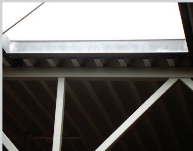
Fot. 3. Dach tej samej hali sklepowej co na fotografii 2. Uszczelnienie profilu trapezowego wokół przejść dachowych (doświetlenia) jest bardzo trudne (drogie) i z tego powodu nie zostało wykonane. Dach nie ma szczelności powietrznej
