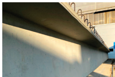
Fot. 2. Prawidłowo wykonana belka
