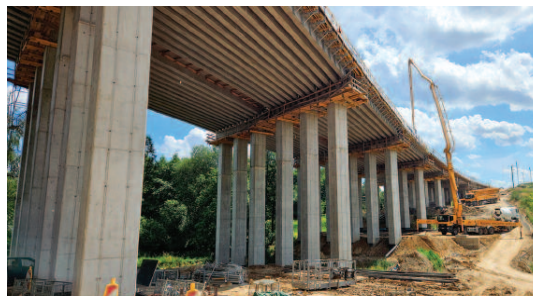
Fot. 1. Budowa obwodnicy Opatowa
