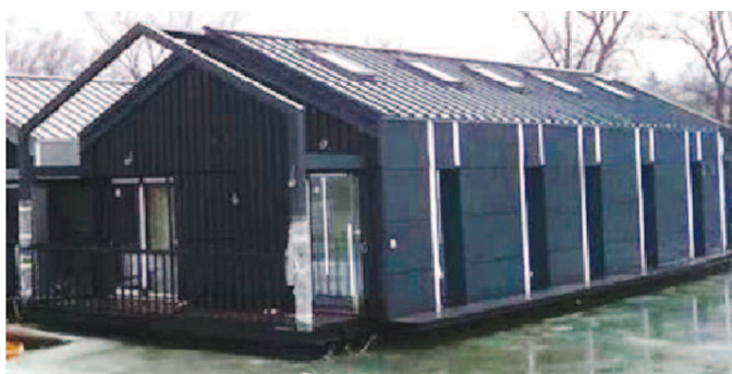
Photo 1. Floating hotel Fot. 1. Pływający hotel
