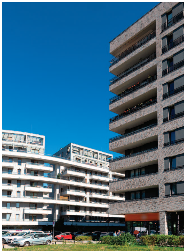
Budynek wielorodzinny zbudowany z wykorzystaniem bloczków silikatowych
