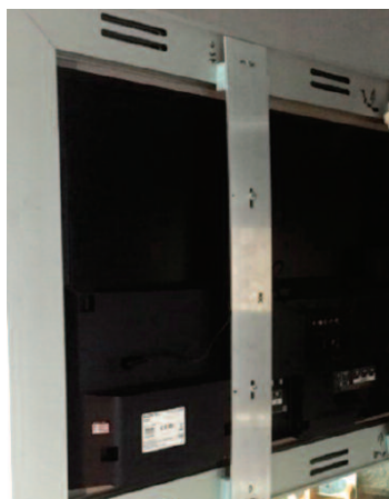
Fot. 1. Prototypowe mocowanie monitora w skrzydle drzwiowym; widoczne są otwory podłużne pozwalające na regulację pozycji monitora po zamontowaniu w skrzydle, zarówno w pionie, jak i w poziomie
