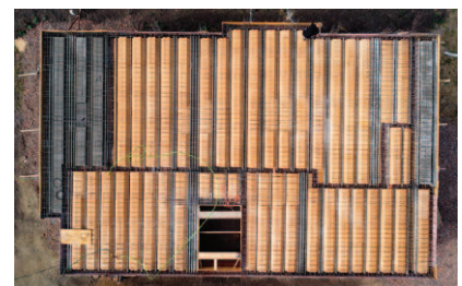
Różne wypełnienia stropów (z paneli oraz pustaków betonowych)
