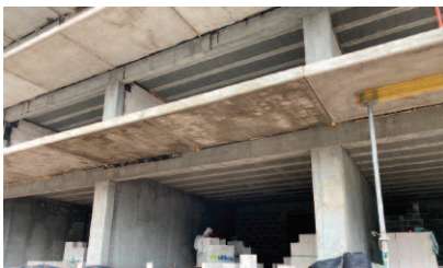
Prefabrykowane płyty balkonowe montowane z systemem RECTOBETON
