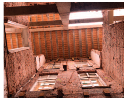
Wymiana stropów w budynku przy ul. Grodzkiej 9 we Wrocławiu
