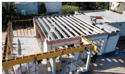
Montaż belek stropowych
