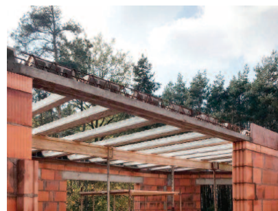
Prefabrykowany podciąg sprężony PPR
