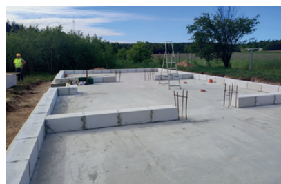
Fot. 3. Warstwa wyrównawcza
