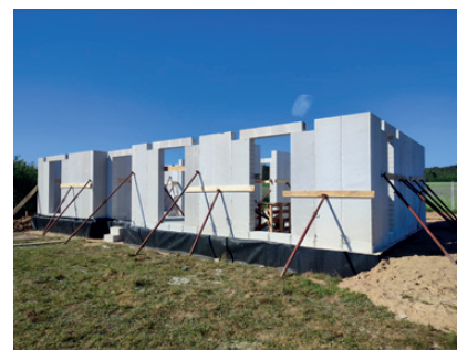
Fot. 5. Zmontowane ściany nośne wraz z nadprożami
