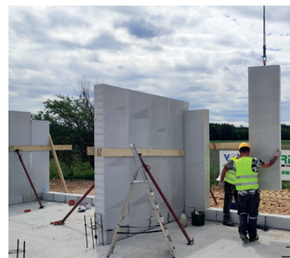
Fot. 4. Montaż elementów EWZ
