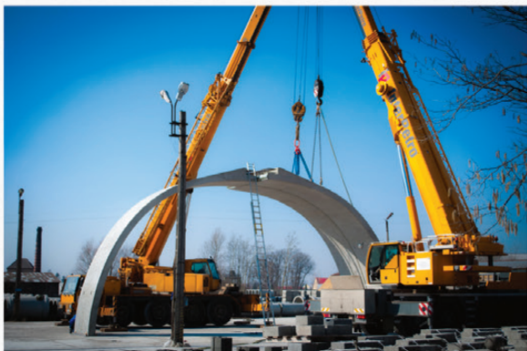
ZAKŁAD BETONÓW W KOLBUSZOWEJ - MONTAŻ ELEMENTÓW ŁUKOWYCH
