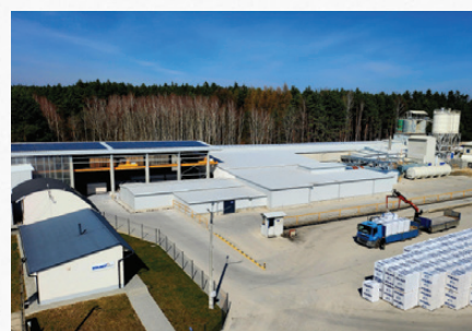
ZAKŁAD BETONÓW W LIPIU
