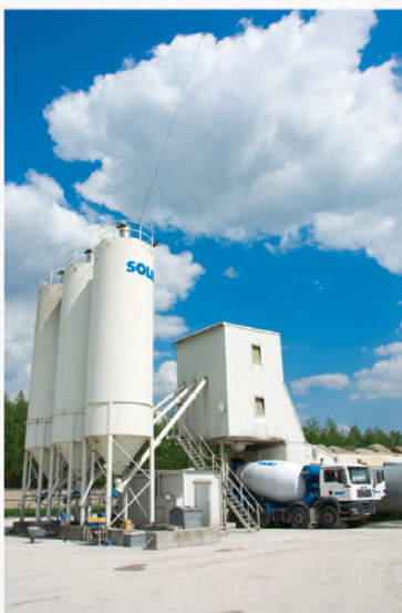
ZAKŁAD BETONÓW W LIPIU - WĘZŁ BETONIARSKI
