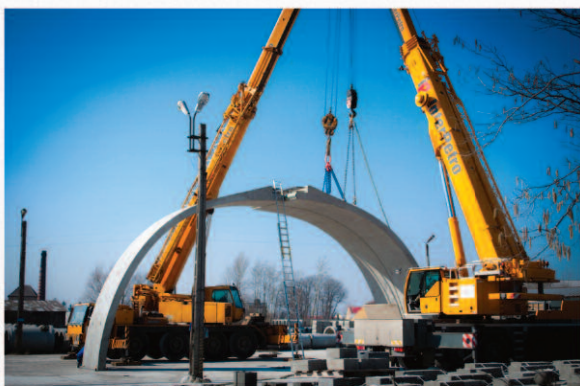
ZAKŁAD BETONÓW W KOLBUSZOWEJ - MONTAŻ ELEMENTÓW ŁUKOWYCH
