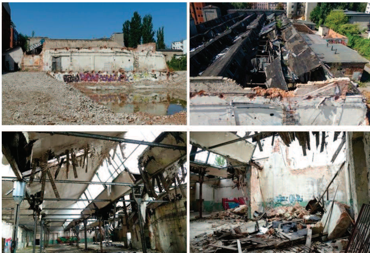
Photo 1. The production hall – current condition of the facility Fot. 1. Hala produkcyjna – obecny stan obiektu
