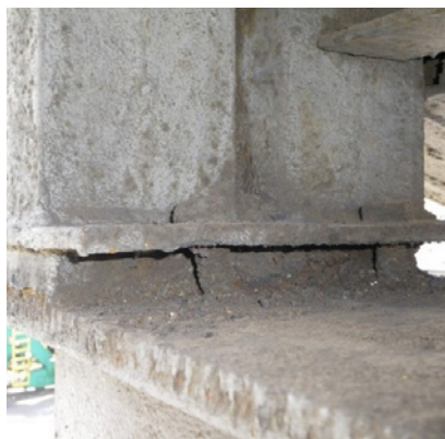
Photo 3. Deformation of the support of the main bridge trusses on the column Fot. 3. Deformacja oparcia kratownic głównych mostu na słupie
