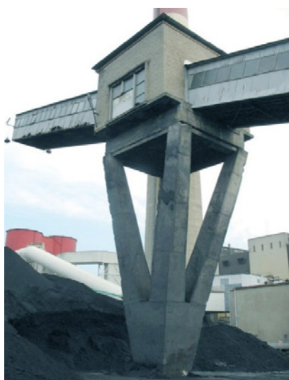
Photo 2. The tower on the coal square Fot. 2. Wieża na placu węglowym
