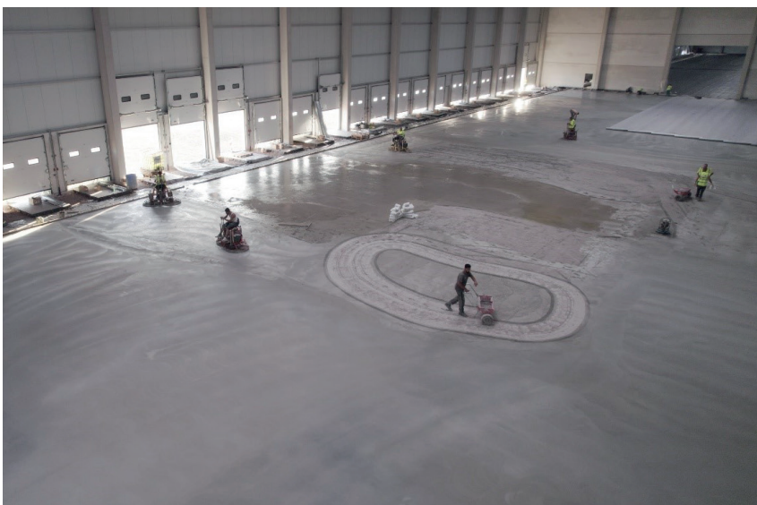
Wykończenie nawierzchni posadzki betonowej zgodnie z wymaganą grubością, równością i płaskością było identyczne jak w przypadku normalnej posadzki betonowej
