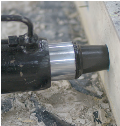
Sprężanie początkowe i końcowe przeprowadzono odpowiednio po dwóch i pięciu dniach od ułożenia mieszanki betonowej
