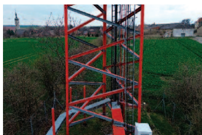
Fot. 1. Existing bracing reinforcement Fot. 1. Istniejące wzmocnienie krzyżulców
