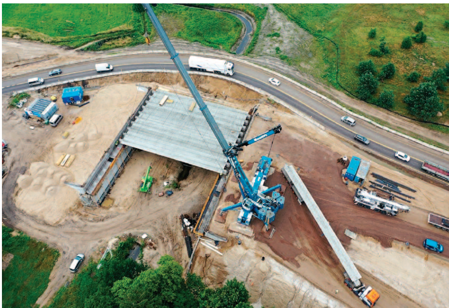
Montaż belek mostowych typu MG-T 40 na placu budowy
