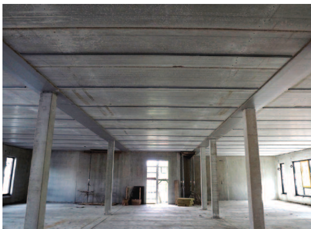
Fot. 3. Strop z płyt kanałowych na belkach Hybridbeam® z efektem slim-floor
