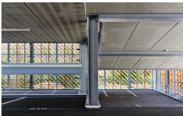
Fot. 2. Konstrukcja rampy parkingu wielokondygnacyjnego z wykorzystaniem belek Hybridbeam® i stropów kanałowych
