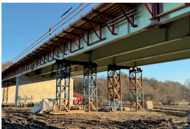
Photo 2. Side view of the part flyover under construction Fot. 2. Widok boczny na część estakady dojazdowej w czasie budowy
