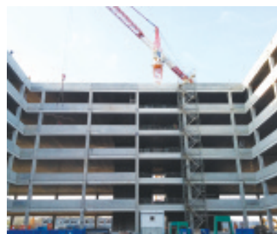
Fot. 2. Sześciokondygnacyjny budynek biurowy w konstrukcji prefabrykowanej
