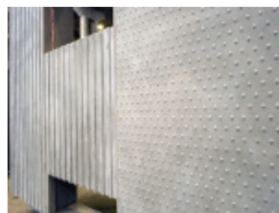
Fot. 3. Warstwa elewacyjna trójwarstwowej ściany prefabrykowanej o zmiennej fakturze
