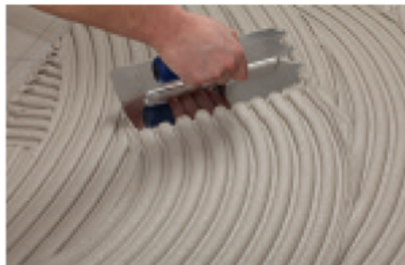
Fot. 2. Do rozprowadzania kleju samorozpływnego należy używać pacy z półokrągłymi zębami
