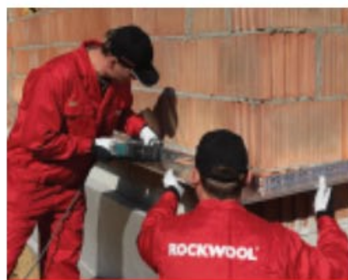
Fot. 2. Instalowanie listwy startowej
