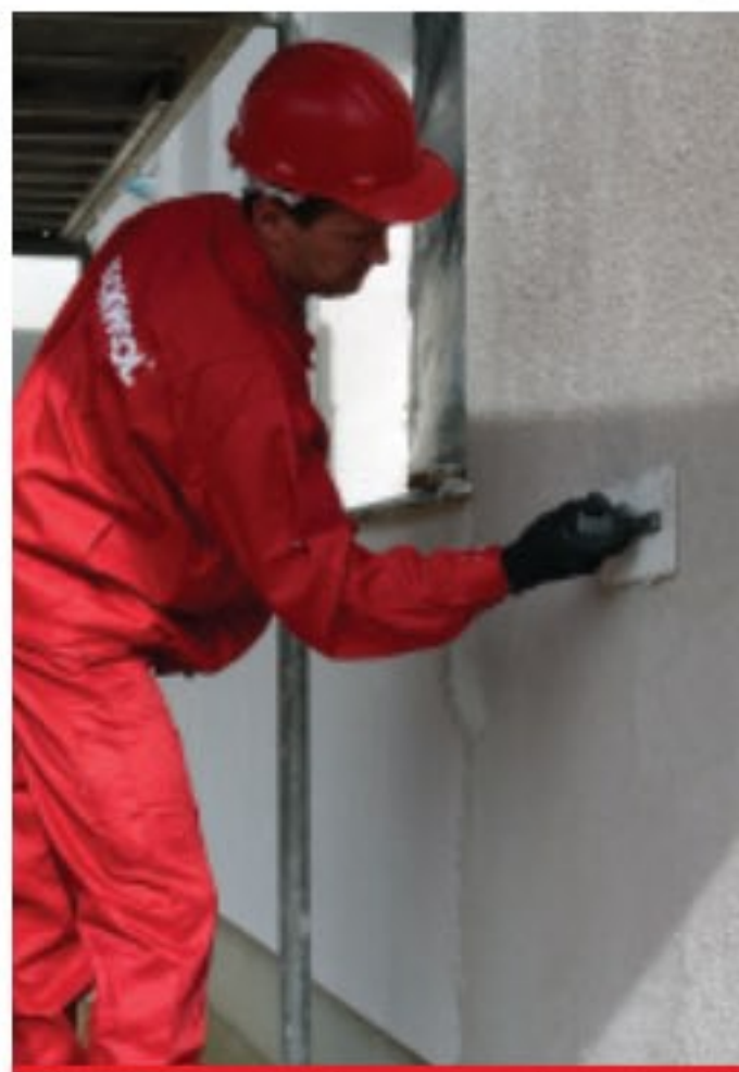
Fot. 3. Nakładanie wyprawy tynkarskiej
