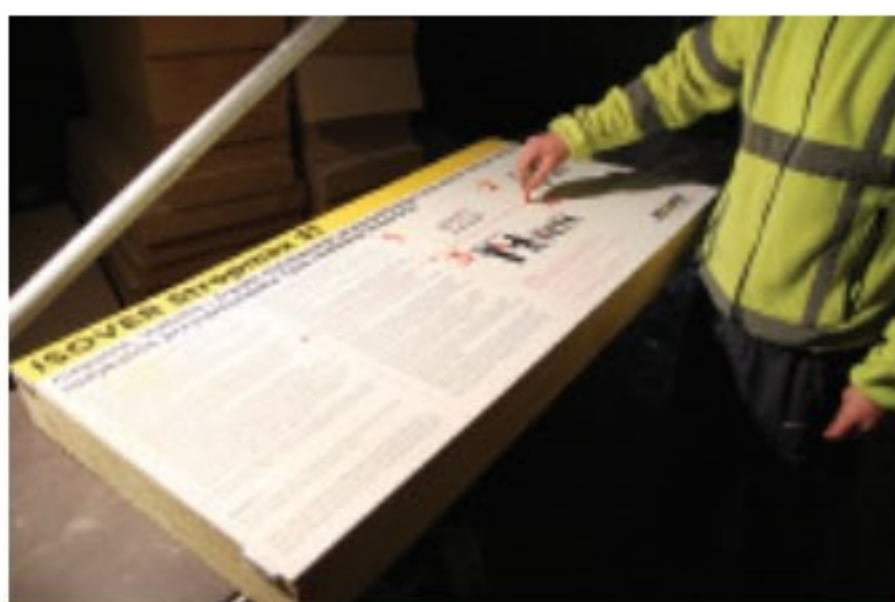
Szablon pomocniczy umożliwiający wyznaczenie punktów odwiertu do mocowania izolacji
