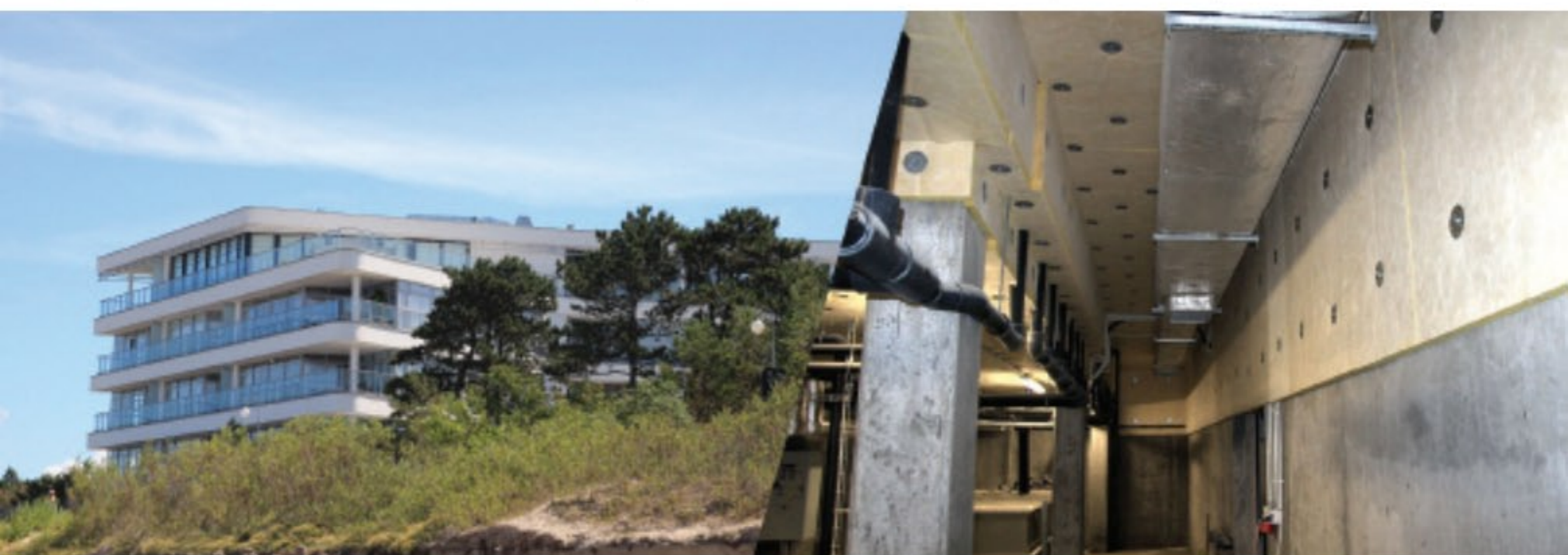
Apartamentowiec z garażem podziemnym w Mielnie
