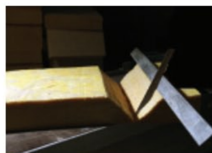
Wycinanie klinów z wełny (do izolowania załamanych powierzchni)
