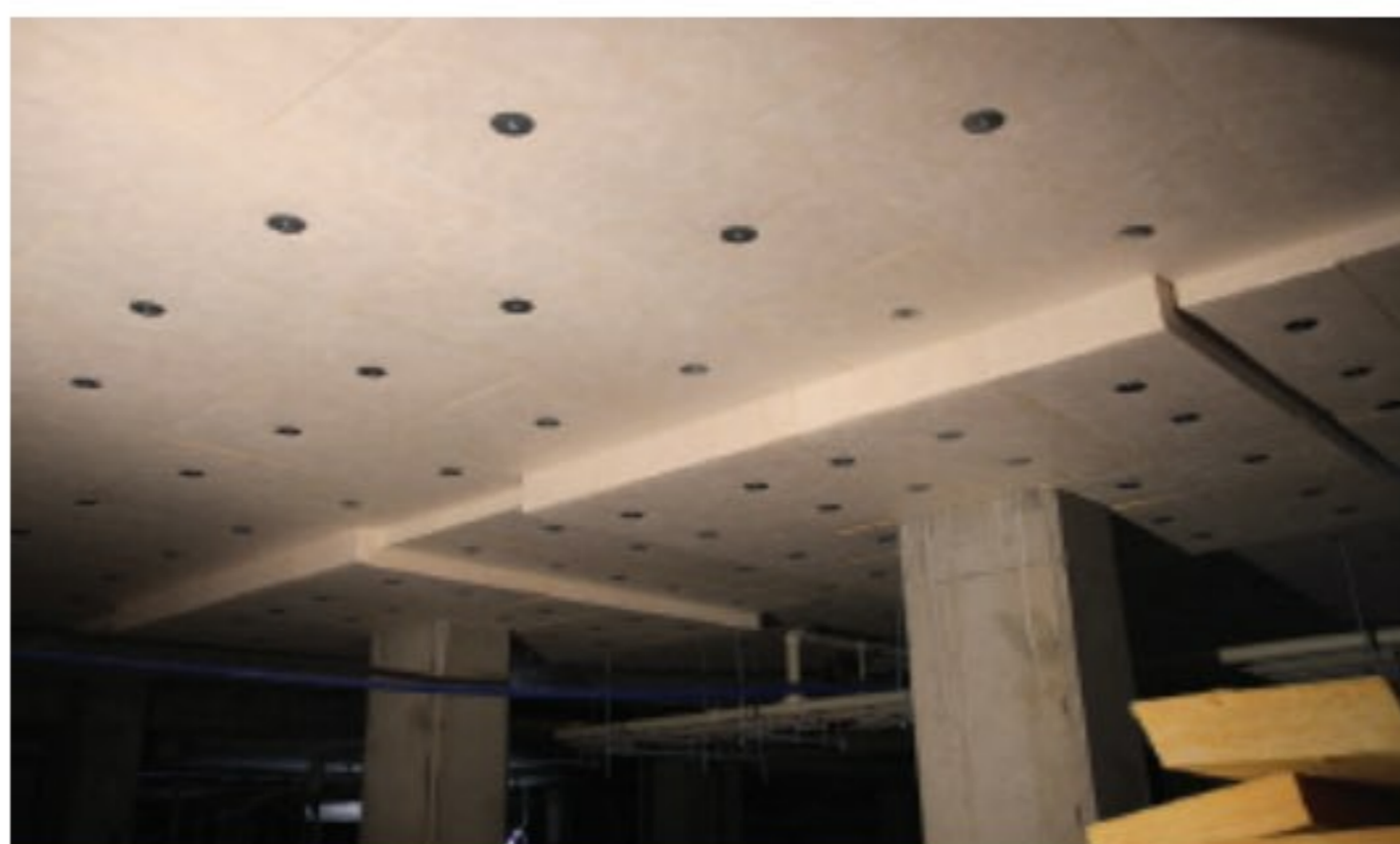
Sufit pełen uskoków – boki izolacji ISOVER Stropmax 31 wykończone są welonem szklanym bez konieczności podklejania jego fragmentów
