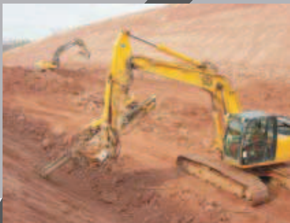
Zabezpieczenie skarp wykopu Droga ekspresowa S 7
