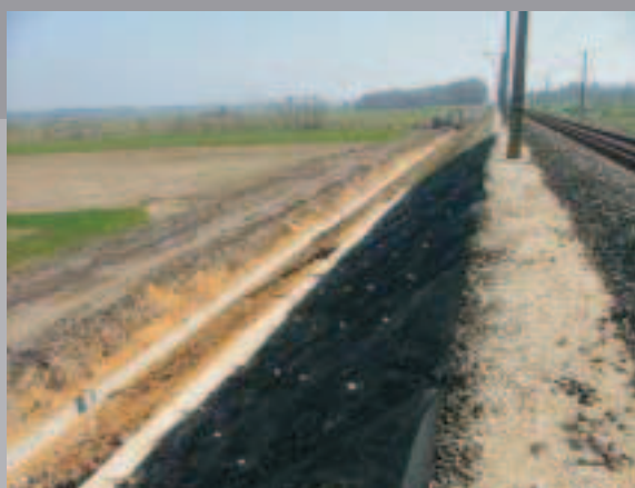
Wzmocnienie nasypu kolejowego Linia E 30
