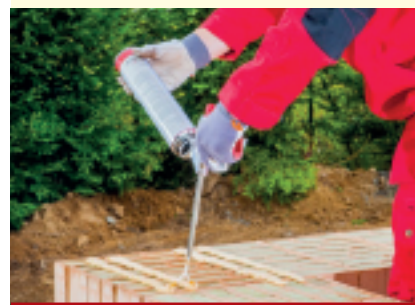
Fot. 3. Murowanie ściany w systemie Porotherm T Profi
