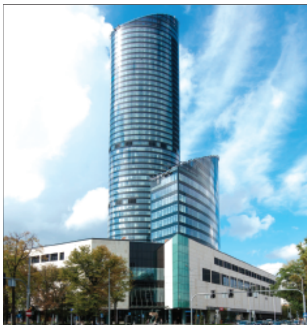
Opisane w artykule rozwiązanie zastosowano m.in. w budynku Sky Tower we Wrocławiu
