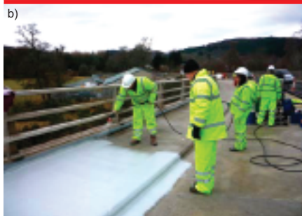
Nanoszenie hydroizolacji MATACRYL® metodą: a) ręczną; b) natryskową
