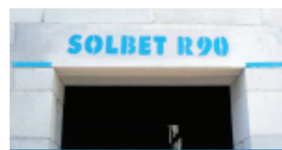
Nadproże SOLBET NS R90 – o podwyższonej klasie odporności ogniowej
