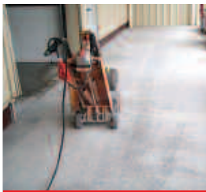
Fot. 3. Przygotowanie do naprawy uszkodzonej posadzki betonowej
