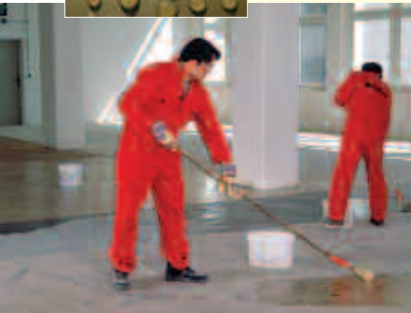
Nanoszenie środka gruntującego
